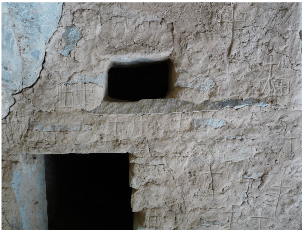
Figura 6. Detalle del frente de la estructura superior
