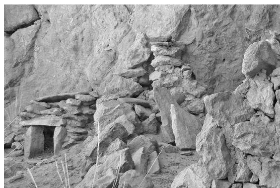
Figura 13. Encuentro sin traba entre la estructura 03 y el muro perimetral, en el Alero 2.
