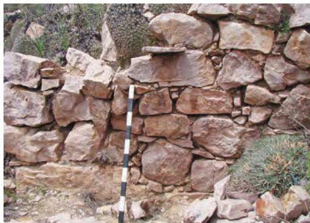
**Fig. 12.** Muro canteado de forma regular construido en cuarcita rosada.
